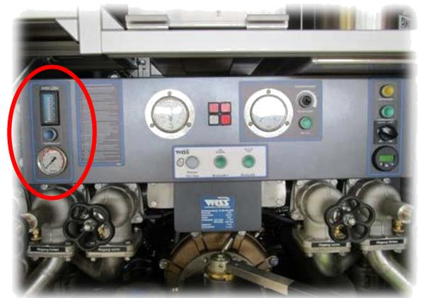
Die Tankfüllautomatik regelt automatisch den Füllstand im Löschwasserbehälter und entlastet somit den Maschinisten.
