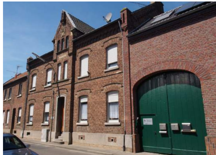
Denkmalwertes Gebäude, Kofferer Straße, Foto RaumPlan.
