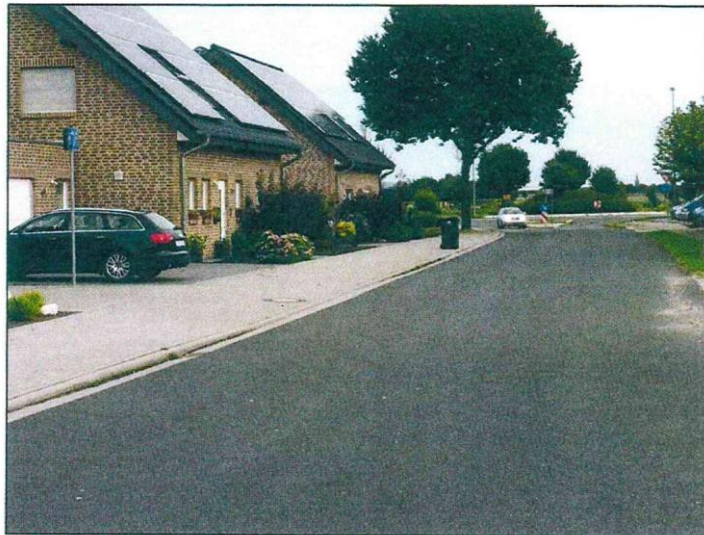
Katzemer Straße Blickrichtung Kreisverkehr
