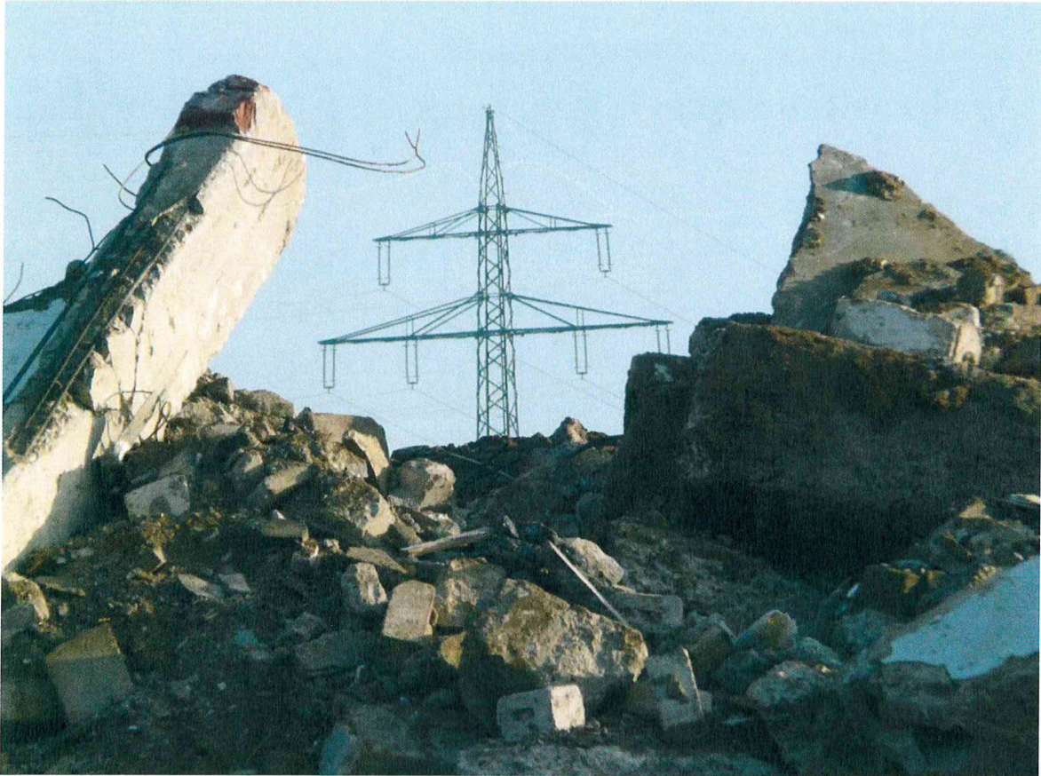
Eingebrachter Bauschutt zur Stabilität.
