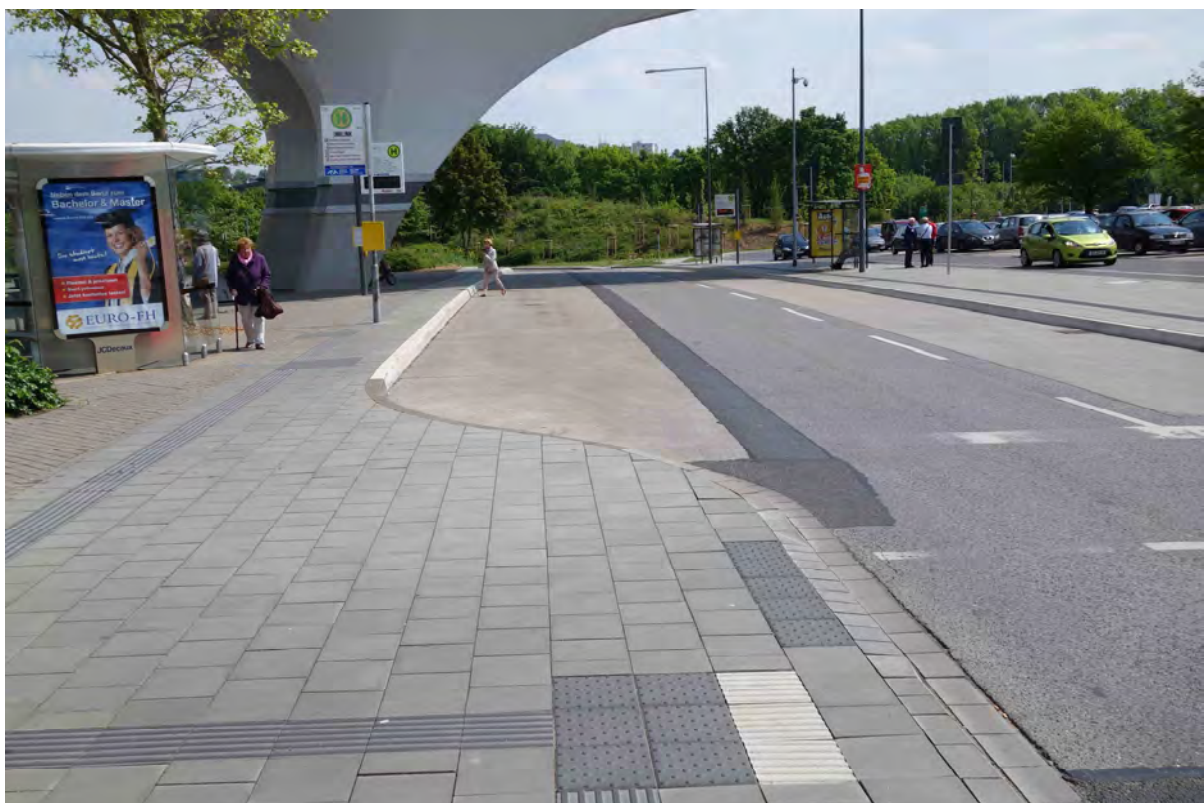
Abb. 117: Barrierefrei ausgebaut Haltestelle Stadt Heinsberg - Industriestraße
