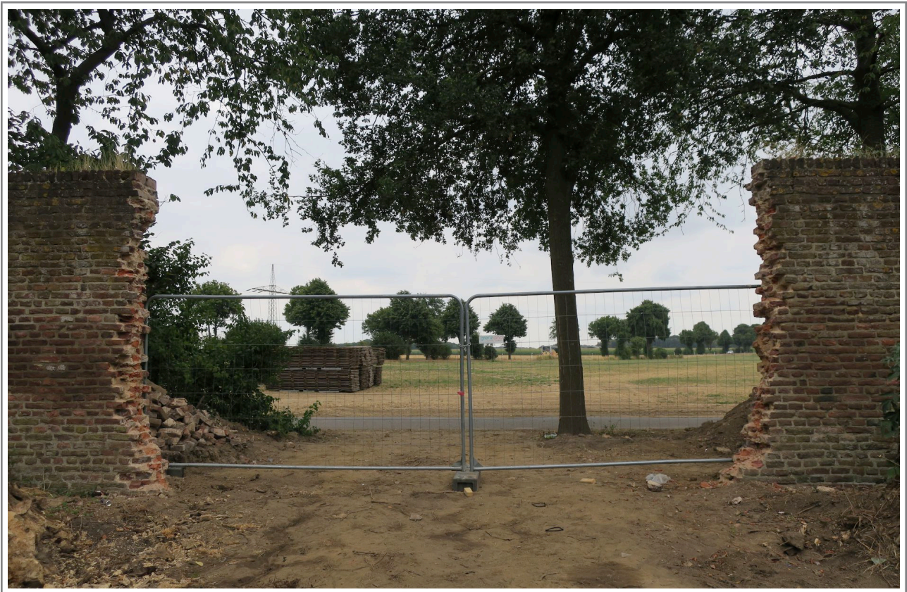
Foto 17: Neuer Tordurchbruch in der südlichen Umfassungsmauer, August 2022
