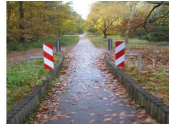
Abb. 5: Barrierefreier Ausschluss von Kraftfahrzeugen durch bauliche Verengung.
