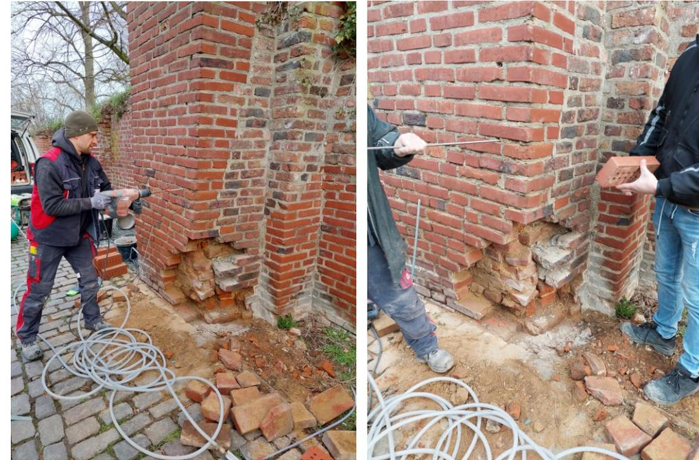
An der Stadtmauer hatte sich eine frühere Mauerschale, die zur Sicherung des Pfeilervorsprungs angebracht war abgesetzt. Das Mauerwerk wurde mit 80 cm langen Mauerankern gesichert, im geschädigten Bereich neu aufgemauert und anschließend verfugt.
