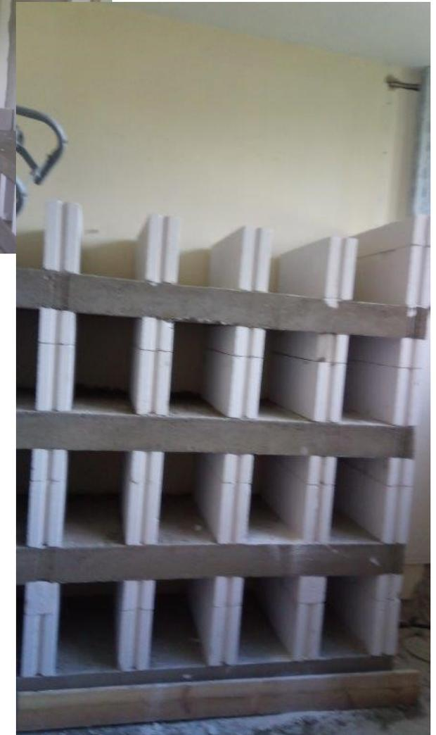
Nach den vorbereitenden Arbeiten werden zurzeit noch die eigentlichen Urnenkammern aus Ytong-Steinen gebaut. Anschließend folgen die Verputz- und Malerarbeiten. In den nächsten Wochen sollen die Arbeiten zügig fortgeführt und abgeschlossen werden. Die Fertigstellung ist zum Ende der ersten Jahreshälfte geplant.
