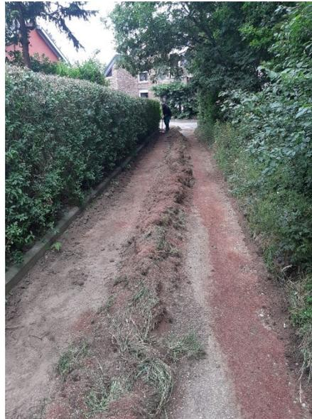
Der wassergebundene Weg war auf einer Länge von ca. 100 m an vielen Stellen verkrautet und stark beschädigt und konnte nicht mehr aufbereitet werden. Deshalb wurde die alte Deckschicht abgeschält und entsorgt. Anschließend wurde die Tragschicht geebnet, neues Wegebaumaterial aufgebracht, verdichtet und die Oberfläche mit einer dünnen Splittschicht abgestreut.
