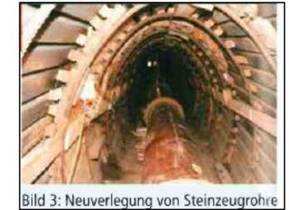
Bild 3: Neuverlegung von Steinzeugrohre
