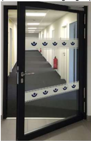
Abb. 3 Sicherheitsmarkierungen bei Ganzglastüren
