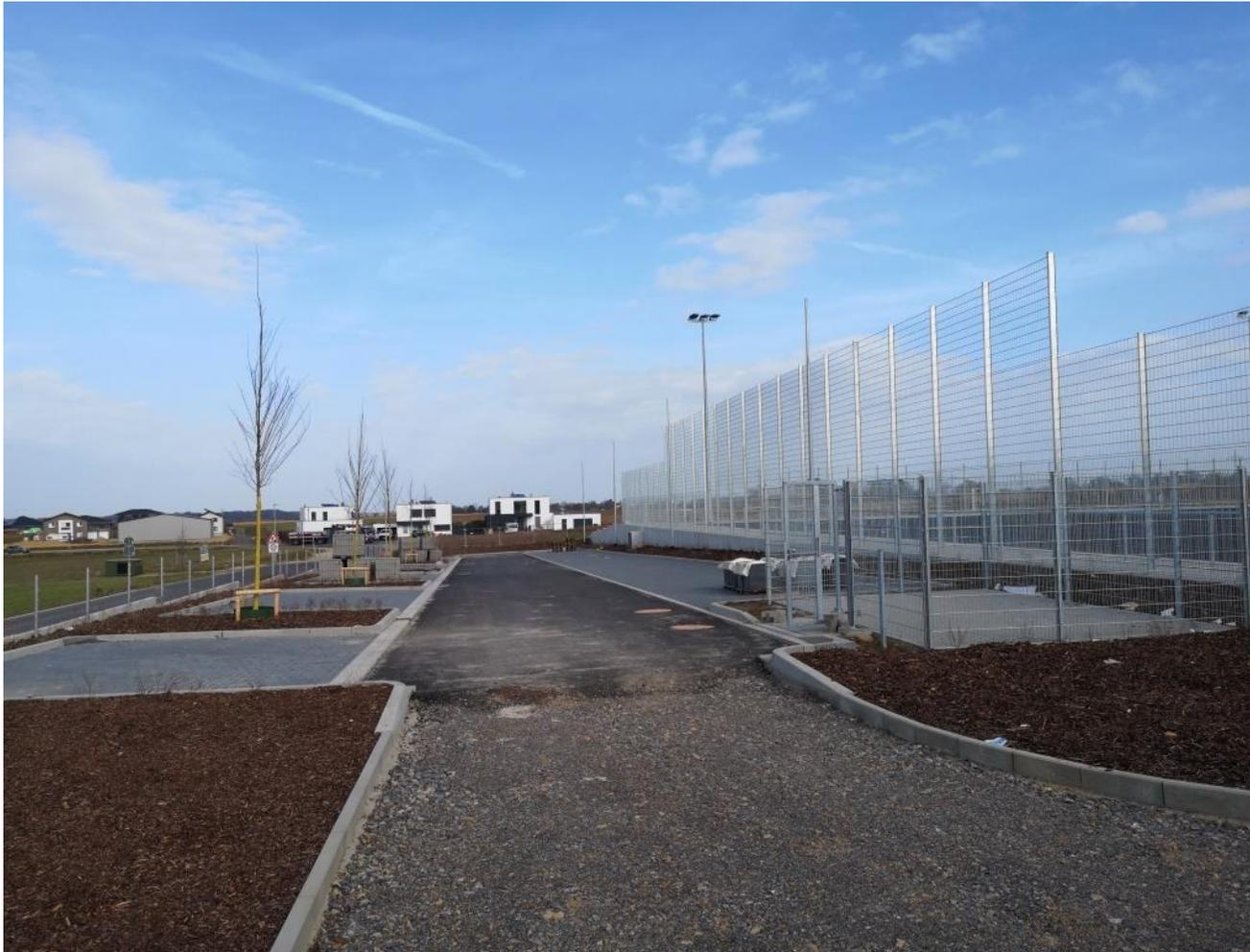
Sämtliche Arbeiten im Parkplatzbereich für die Sportanlage wurden abgeschlossen. Dazu zählen die bituminöse Zufahrt, die Stellplätze in pflasterbauweise sowie die Begrünungsmaßnahmen.
