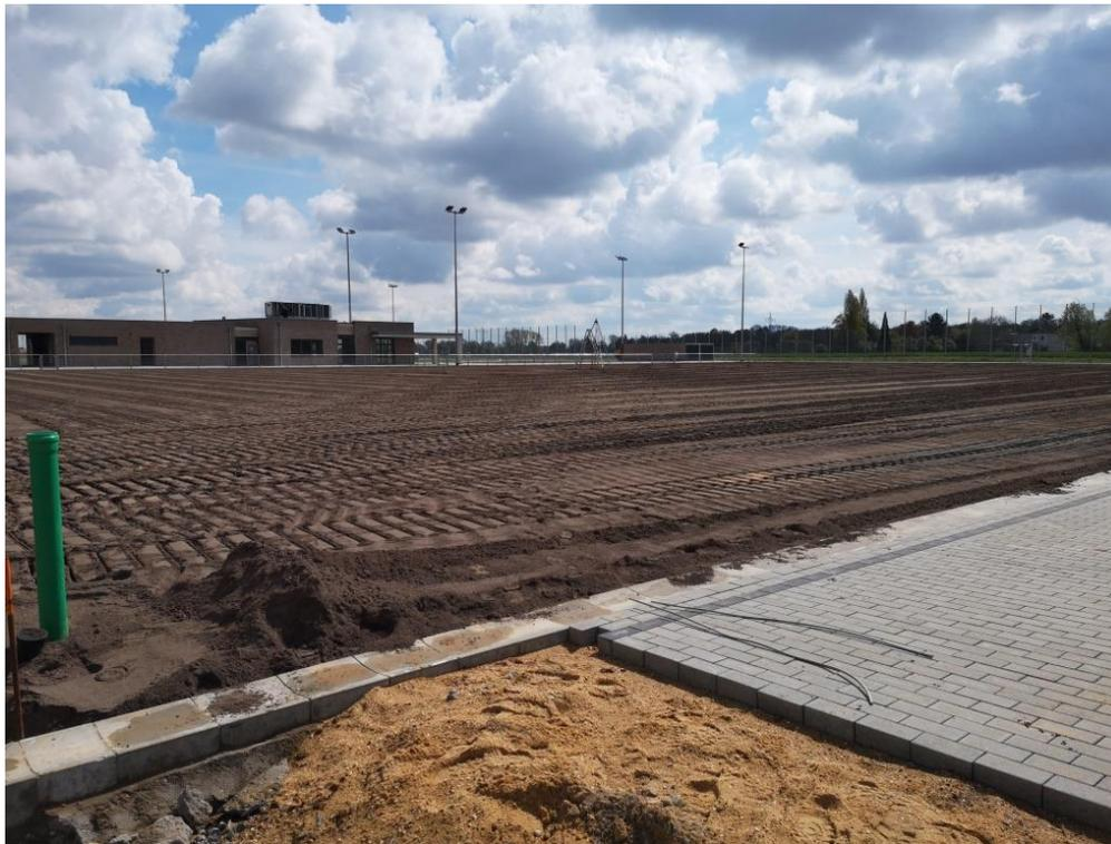
Zurzeit ist die Firma Heiler damit beschäftigt, den Rasenplatz anzulegen. Die Einsaat ist erfolgt, der Platz wurde angewalzt und gedüngt. Die Beregnungsanlage ist eingebaut und die Steuerung im Gebäude aufgehängt. Darüber hinaus wurde die Pumpe für die Zisterne eingebaut, so dass die Anlage jetzt betriebsfertig ist. Damit ist die erforderliche Bewässerung der Ansaat des Naturrasens gewährleistet.
