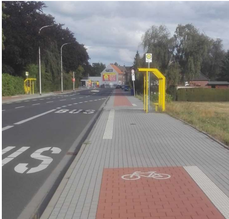
HST: HS-Oberbruch, Birkenweg (K5)
